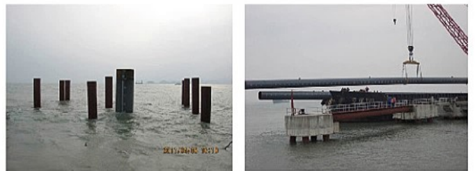
钢管复合桩吊装运输与沉桩
