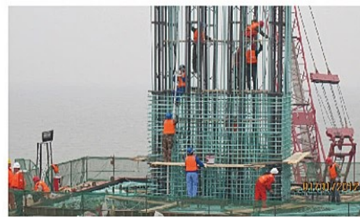
高性能涂层钢筋在港珠澳大桥现场应用
