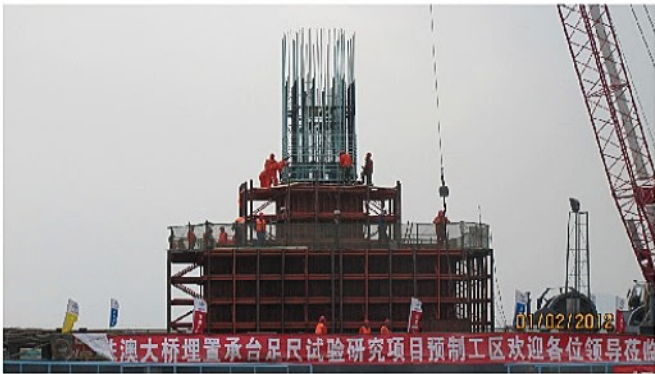
金属所参与港珠澳大桥埋置承台足尺试验研究项目
